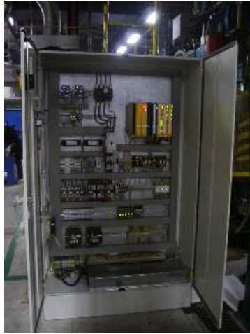
Szafa sterownicza prasy ze sterownikiem PSS.
